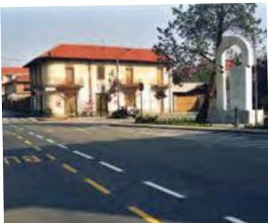
STAZIONE dal 05/04/1987 al 27/06/2002
